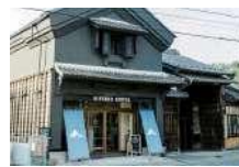
備蓄庫として使われていた築100年を超える蔵を改修。
